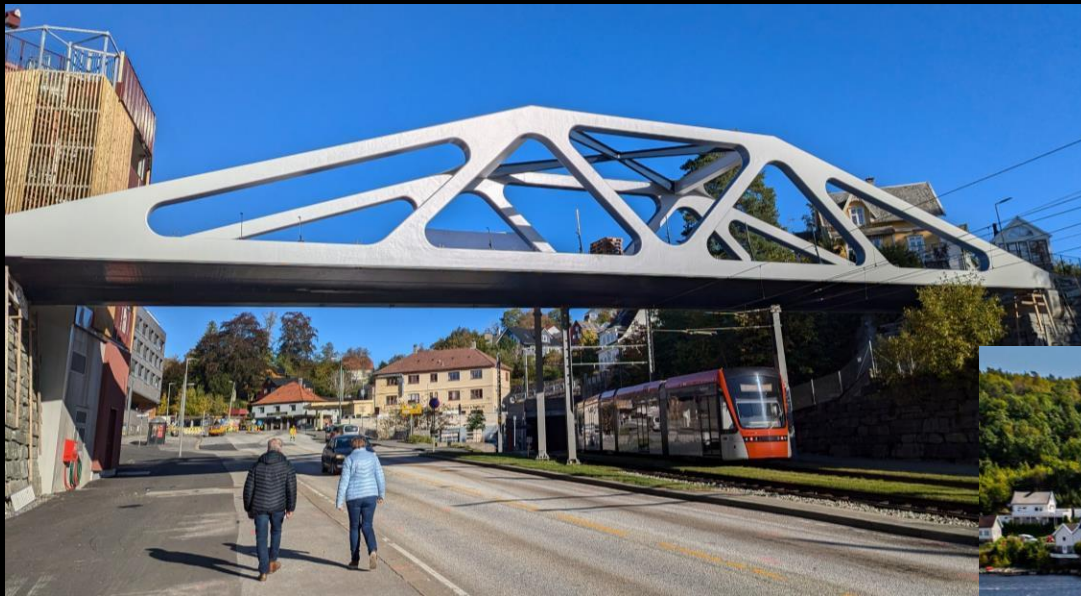
Bro i Paradis, Bergen. Verdens lengste FRP fagverksbro over vei og bybane. (Foto: CSUB)
